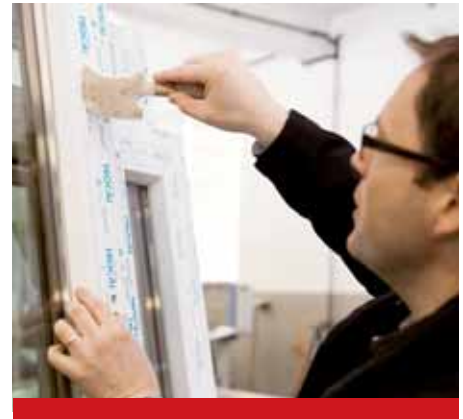
Stekla PVC-oken zamenjajo v nekaj minutah, saj letvice enostavno odstranijo in steklo takoj zamenjajo.
