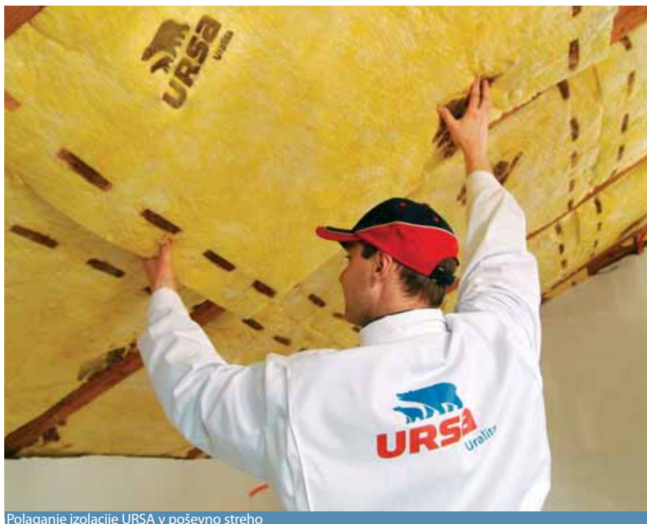
Polaganje izolacije URSA v poševno streho
