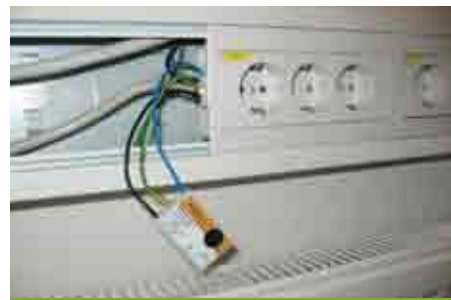
Nameščena III. stopnja prenapetostne zaščite pred porabnikom
