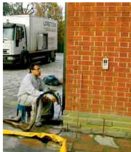
Poseg na zunanji nosilni steni
