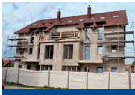
Nizkoenergetski večstanovanjski objekt A 5 je v zaključni fazi gradnje.
