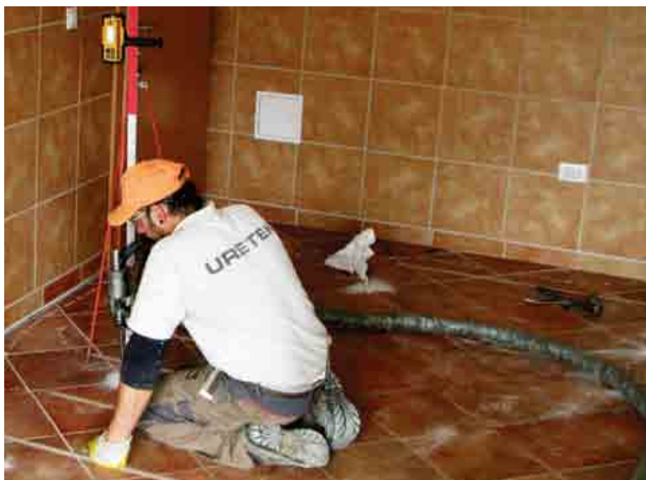
Uretek opravi sanacijo posedenega tlaka hitro in učinkovito.
